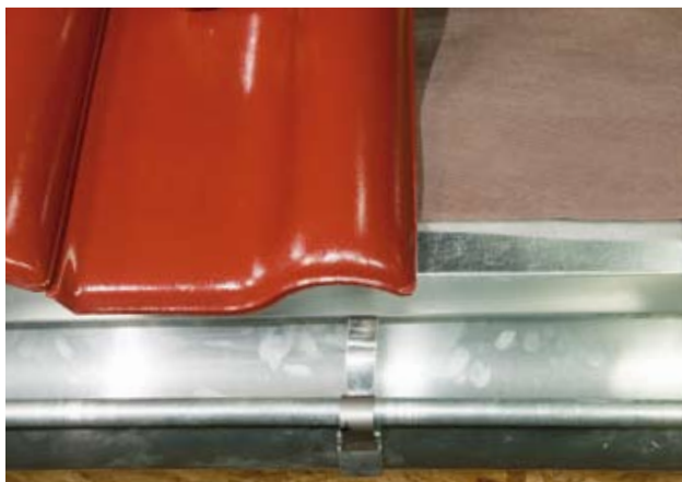
Okap z folią do pasa nadrynnowego (z nisko wiszącą rynną)
