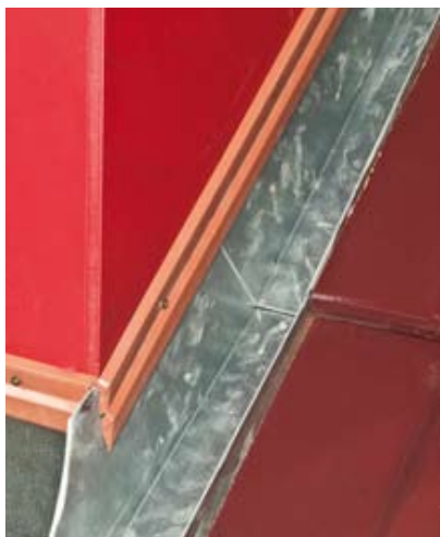
Obróbka pod dachówką
