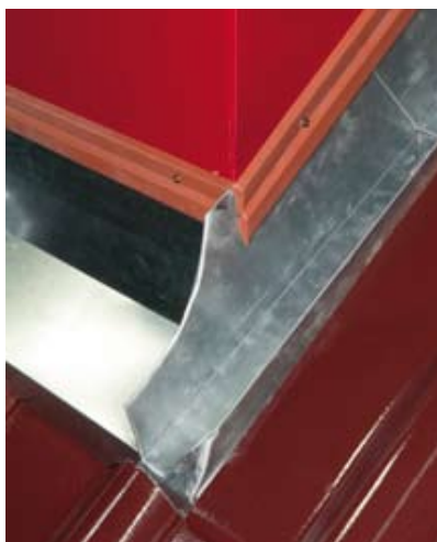
Połączenie na tzw. rąbek stojący
