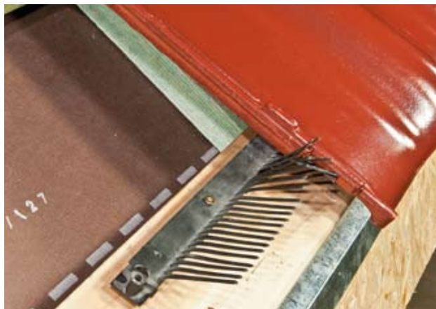
Okap z folią do pasa podrynnowego (z wysoko wiszącą rynną)
